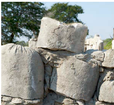
Erbaut wird das Camp mit alten Maissäcken, die mit Beton gefüllt werden – das spart Geld und man ist nicht von Lieferungen abhängig, meint der stolze Neo-Unternehmer.
